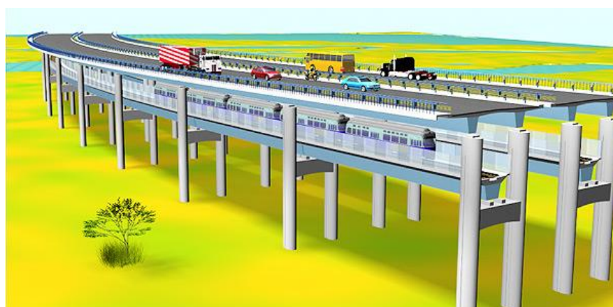
Рис.2 - Совмещенная эстакада на Подольском мостовом переходе в Киеве
