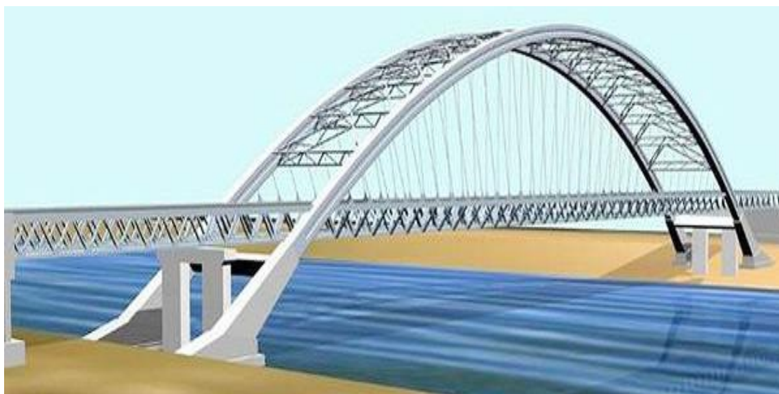
Рис.3 - Совмещенный арочный мост через Днепр в Киеве.
